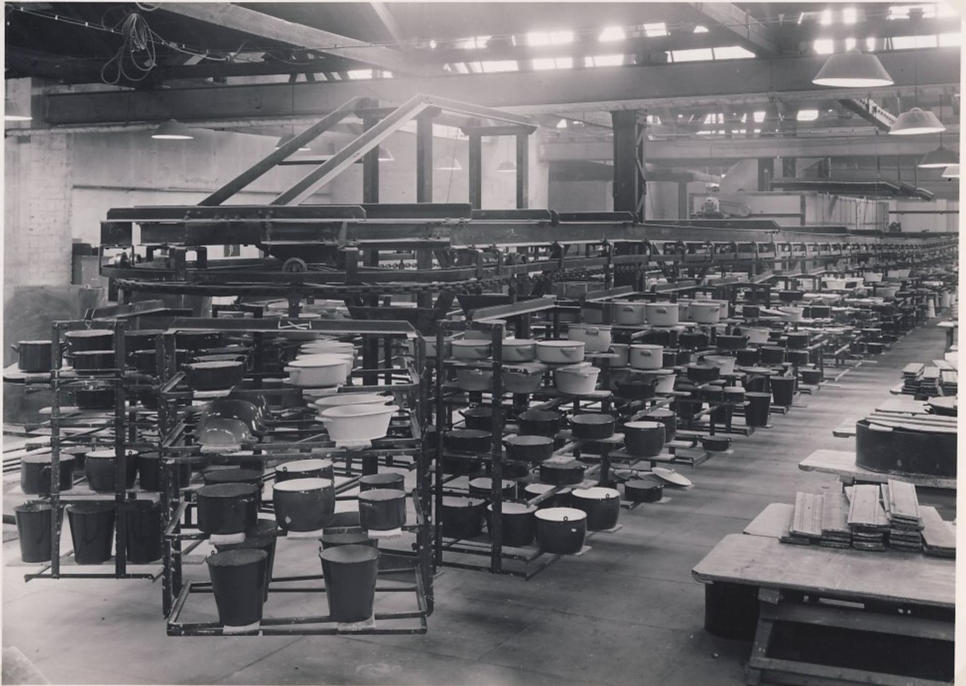
74 mehrstöckige Trockenhorden laufen an den Arbeitsstellen der Aufträger vorüber. Die aufgetragenen Geschirre werden auf diese Horden abgestellt und wandern durch den eigentlichen Trockenkanal. Am Ende des Trockenkanals sind sie einwandfrei und gleichmäßig getrocknet. Zur Beheizung dienen die Abgase des Umkehr-Emallierofens.
